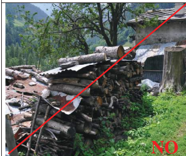
Fig.3- Coperture arrugginite e mal posizionate
