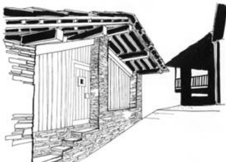
la chiusura dello sfondato è realizzata con un tamponamento ligneo posizionato in accentuato arretramento rispetto al piano di facciata al fine del mantenimento dell'effetto plastico delle parti in muratura
