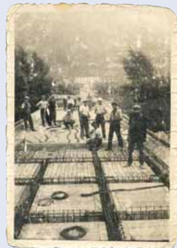
Operai alle prese con l'armatura della soletta di copertura Ouvrie què fan l'armaduro dè la souletto dzuri
